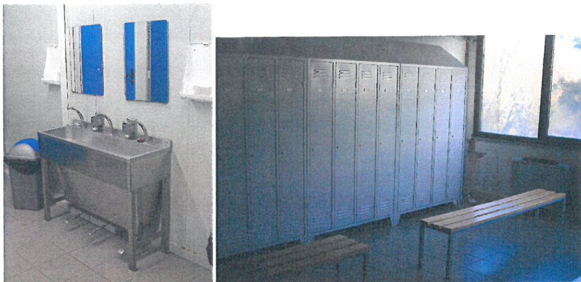
Lavello con tre erogatori acqua, due specchi, due porta asciugamani, un contenitore rifiuti in plastica. A destra: armadietti metallici e due panche.
